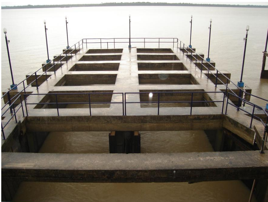
Fotografia 15: Canal de Aproximação
