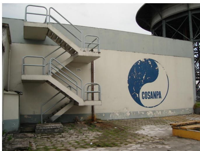
Fotografia 54: Reservatório Apoiado ETA São Braz
