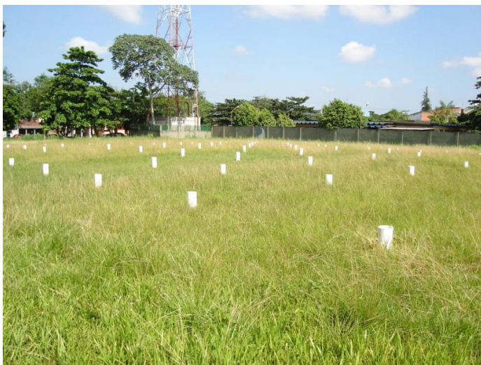
Fotografia 50: Reservatório enterrado ETA 5º Setor
