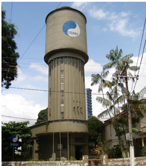
Fotografia 61: Reservatório apoiado do 2º Setor de abastecimento
