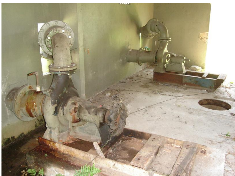
Fotografia 71: Bomba de recalque (cisterna – poço de captação)
