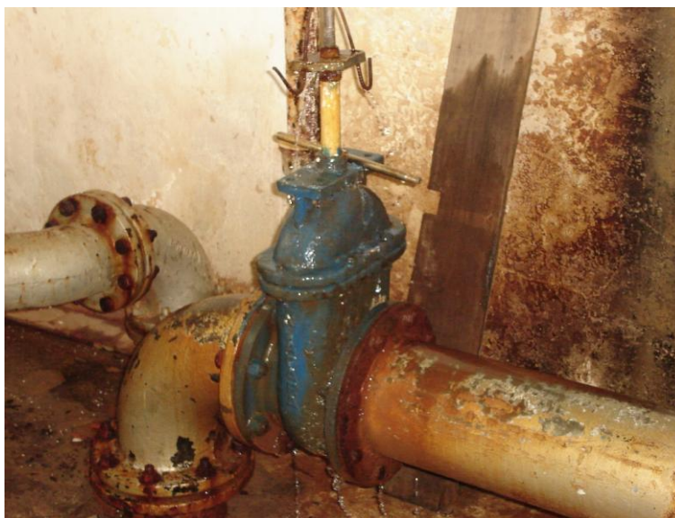
Fotografia 91: Sistema de lavagem dos filtros de areia – ETA 5º Setor
