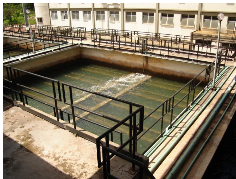
Fotografia 43: Filtro de escoamento descendente ETA Bolonha
