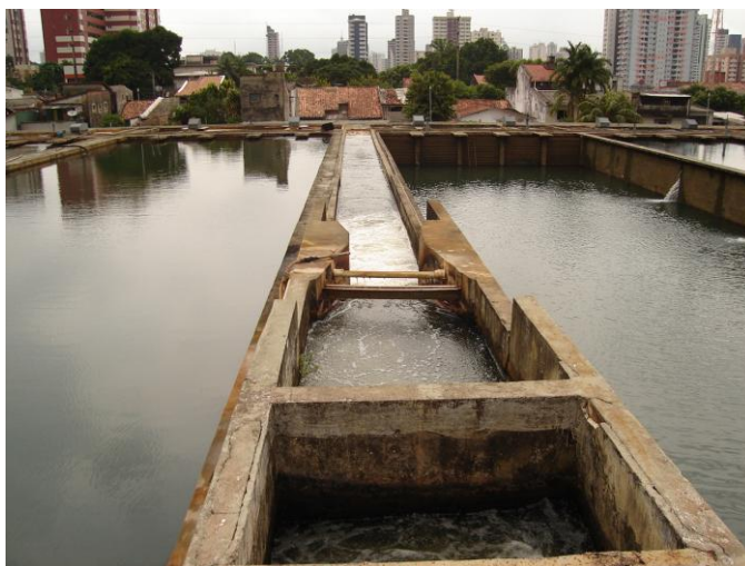
Fotografia 53: Estação de Tratamento de Água (ETA) de São Braz
