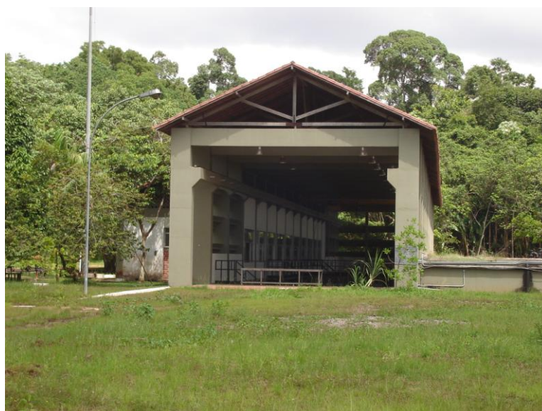
Fotografia 45: Estação Elevatória de Água Tratada (EAT) Bolonha
