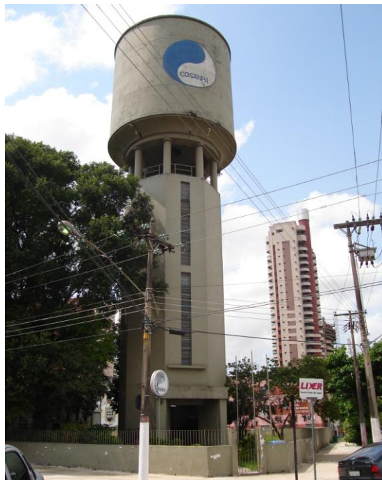
Fotografia 64: Reservatório apoiado do 3º Setor de abastecimento
