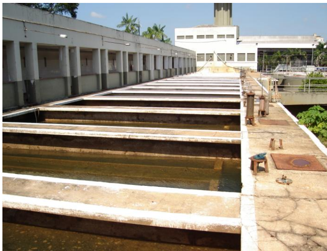
Fotografia 49: Filtros de areia da ETA 5º Setor
