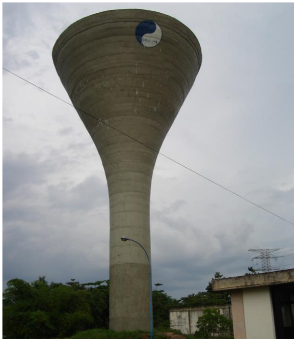
Fotografia 79: Reservatório apoiado do 7º Setor de abastecimento
