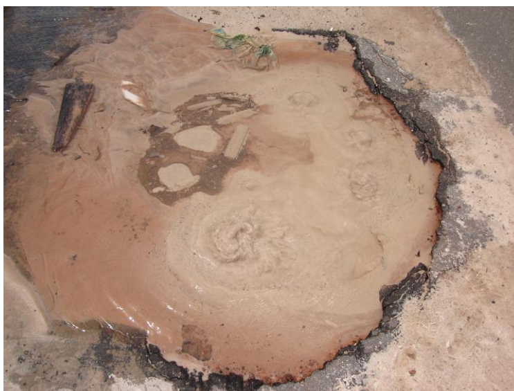
Fotografia 88: Vazamento Aflorante
