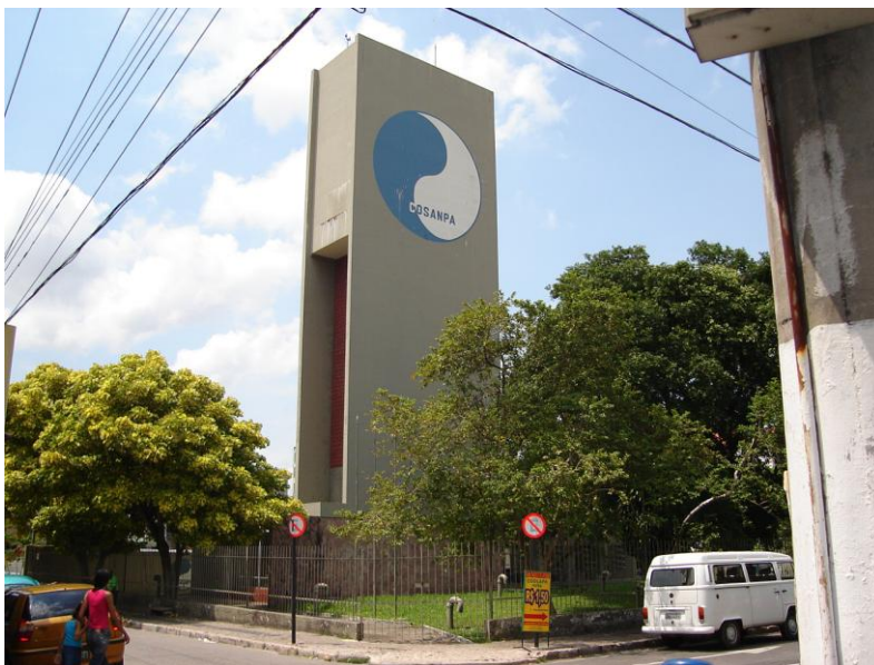
Fotografia 58: Reservatório apoiado do 1º Setor de abastecimento
