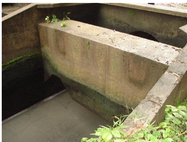
Fotografia 30: Dissipador de energia
