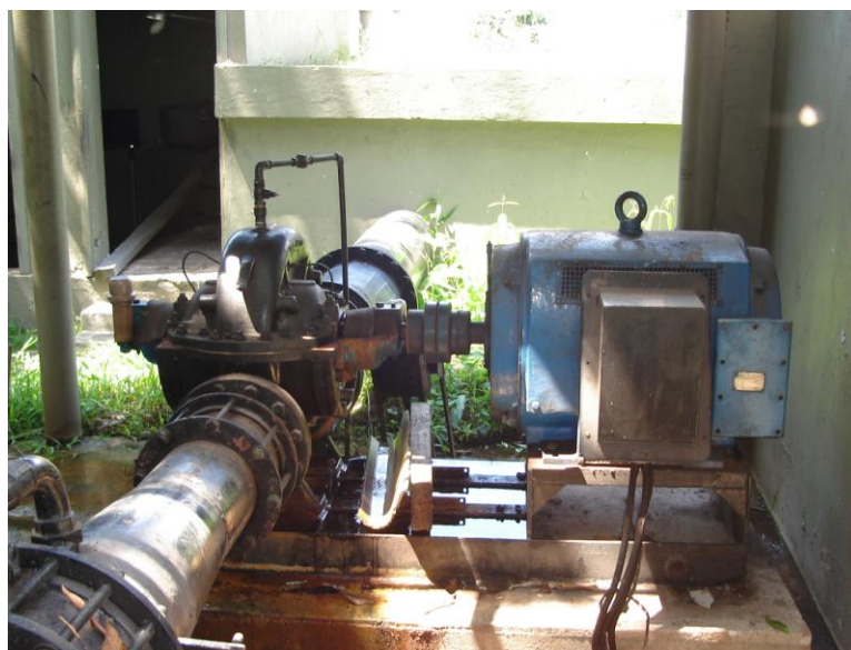
Fotografia 71: Bomba de recalque (cisterna – poço de captação)
