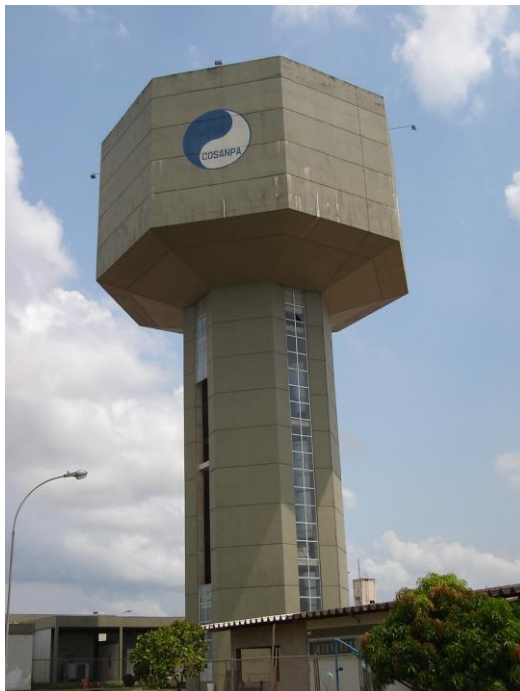
Fotografia 82: Reservatório apoiado do 8º Setor de abastecimento
