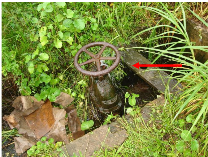
Fotografia 37: Vazamento na adutora Utinga – São Brás
