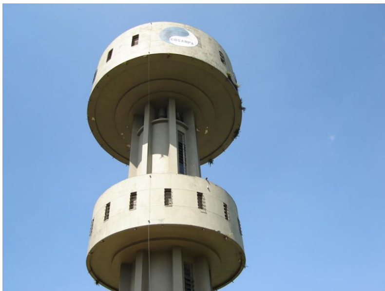
Fotografia 73: Reservatório apoiado do 5º Setor de abastecimento
