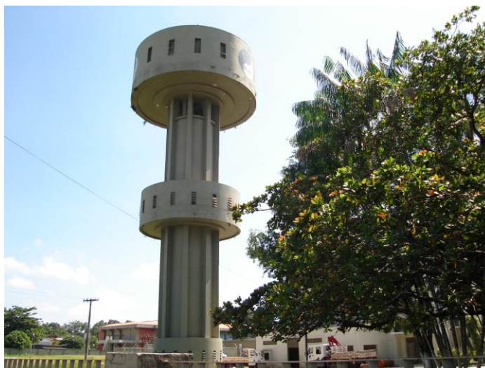
Fotografia 51: Reservatório elevado ETA 5º Setor
