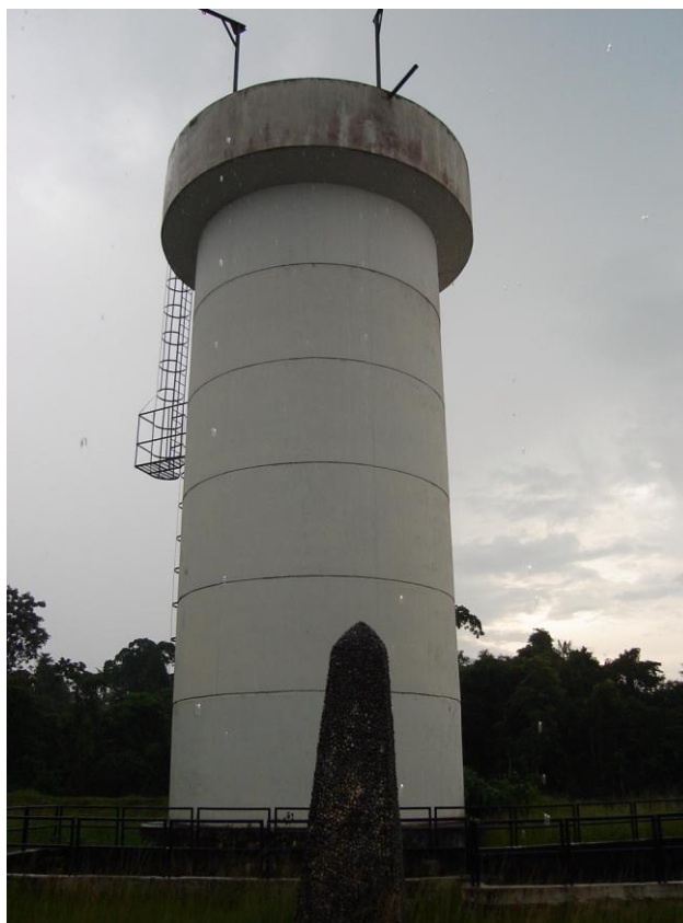
Fotografia 31: Tanque Amortecedor Unidirecional
