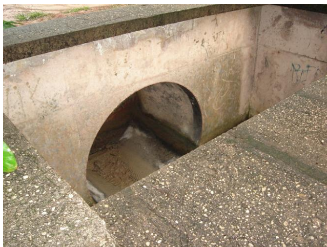
Fotografia 28: Chegada Tamponada da segunda adutora de 1.500mm no dissipador de energia
