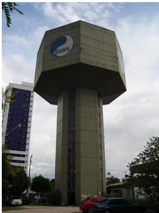
Fotografia 85: Reservatório apoiado do 9º Setor de abastecimento
